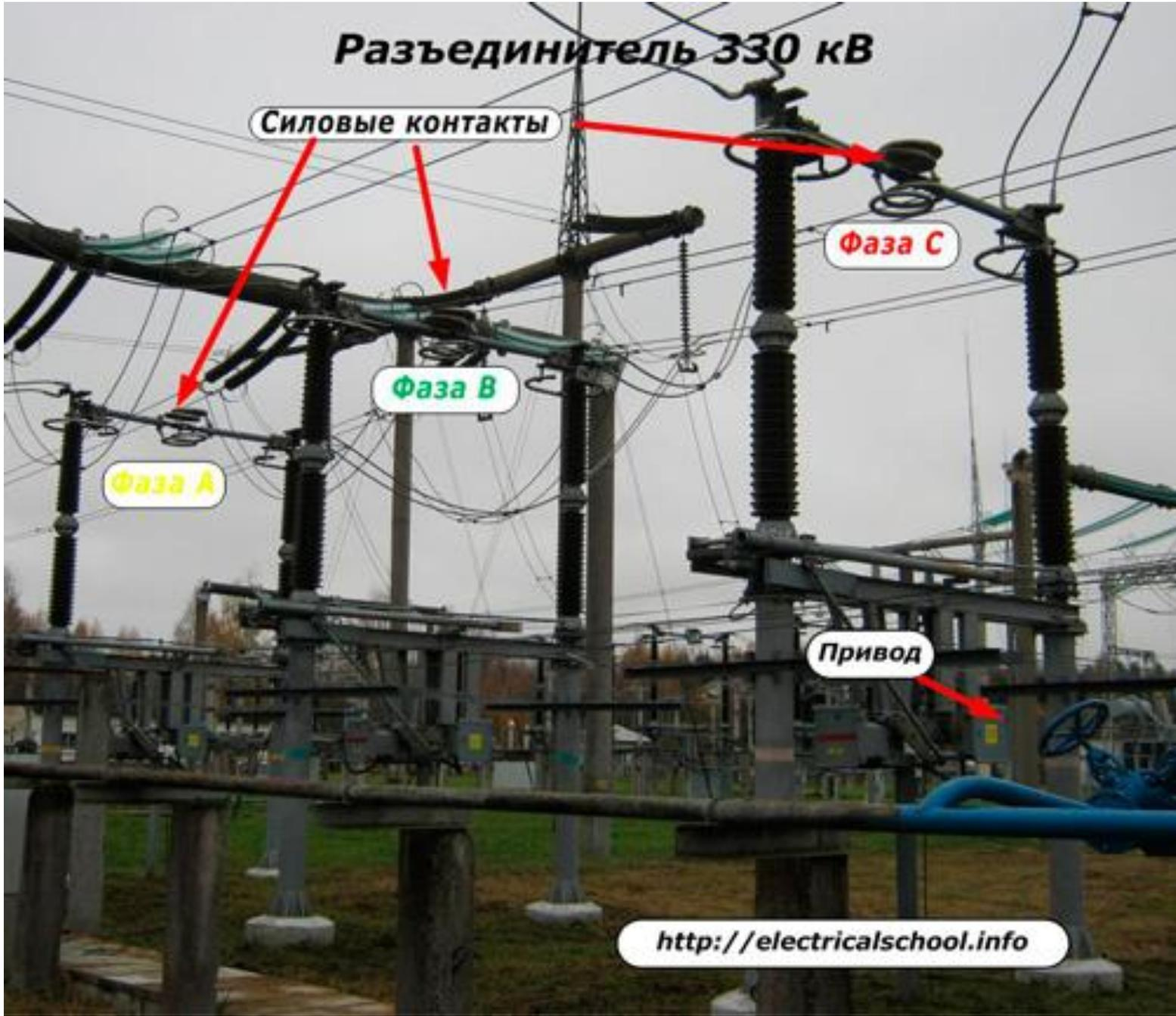
Разъединители по числу полюсов могут быть одно- и трехполюсными, по роду установки - для внутренних и наружных установок, по конструкции - рубящего, поворотного, катящегося, пантографического и подвесного типа.
