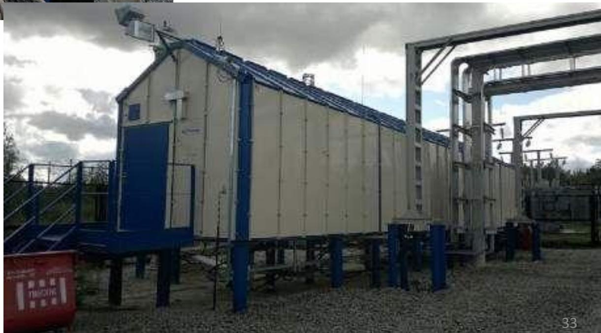
**РУ** состоящее из полностью или частично закрытых шкафов и блоков со встроенными в них аппаратами устройствами защиты и автоматики, поставляемое в собранном или подготовленном для сборке виде называют – **комплектным**, и обозначают:
